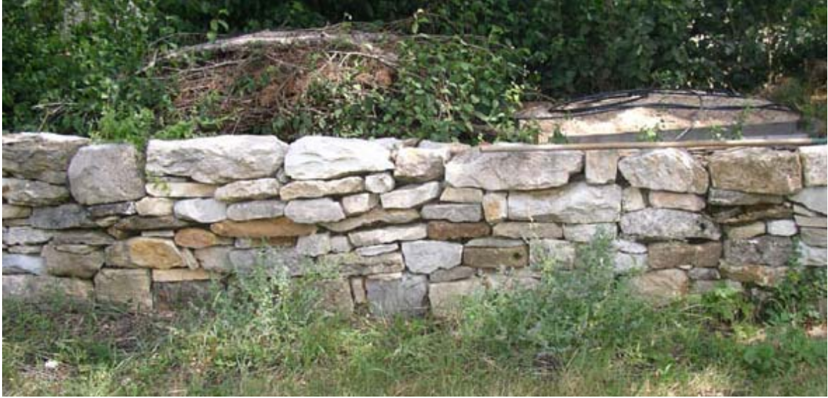
Figure 20 : Illustration d'un mur en pierre sèche
