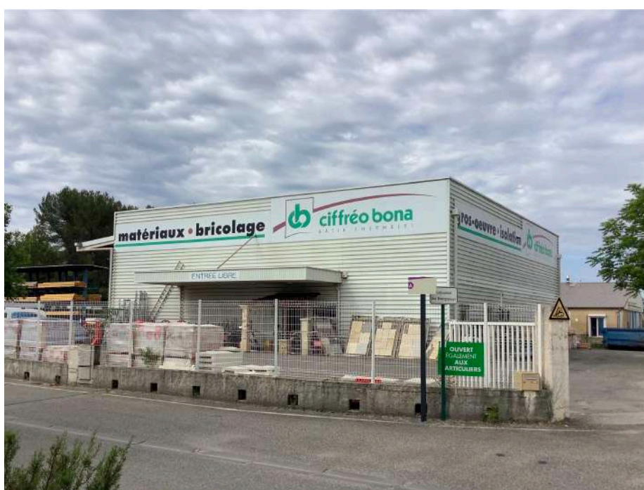
Enseignes parallèles au mur en zone d'activités, Vinon-sur-Verdon, juin 2022.
