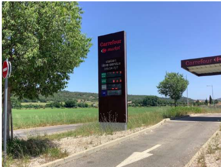
Enseigne scellée au sol de plus de 6 m 2 , Vinon-sur-Verdon, juin 2022.
