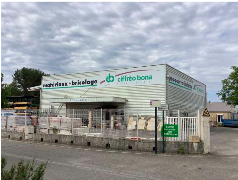
Enseignes parallèles au mur en zone d'activités, Vinon-sur-Verdon, juin 2022.
