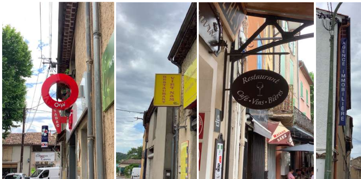
Enseignes perpendiculaires au mur, Vinon-sur-Verdon, juin 2022.
