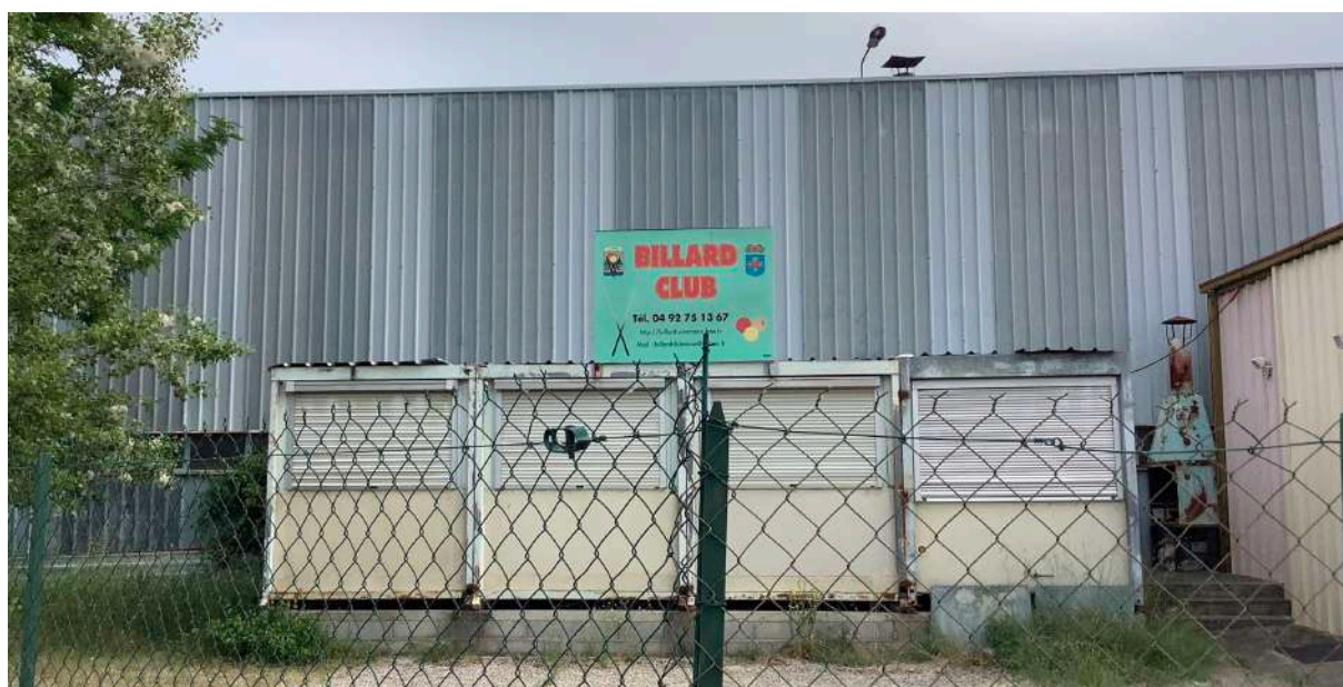
Enseigne sur toiture en panneau sur fond, Vinon-sur-Verdon, juin 2022.
