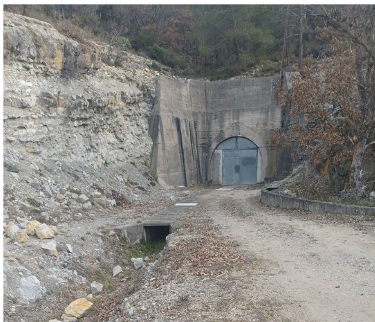
L'entrée de la galerie des Maurras en partie aval (travaux préparatoires en cours)
